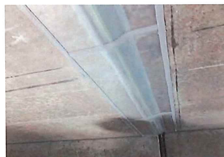
段差のある目地に施工した例
