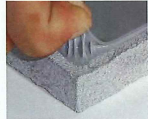
敷設後、端部を少し引き上げて、系引き状態を確認してください。
