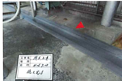
建屋内排水路防水(塗装の代替)の例
