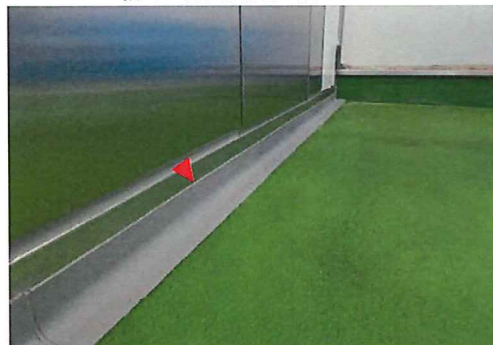
建屋内排水路防水(塗装の代替)の例
