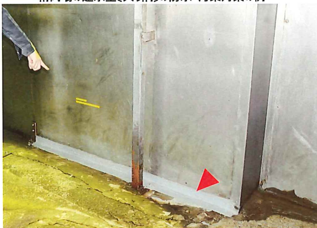
魚肉加工場の〔入り隅目地〕 防水・害虫対策の例
