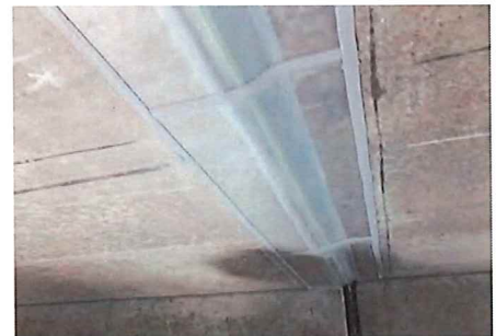
段差のある目地に施工した例
