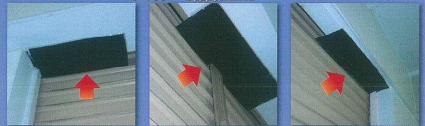
シャッターの隙間(設置後)
