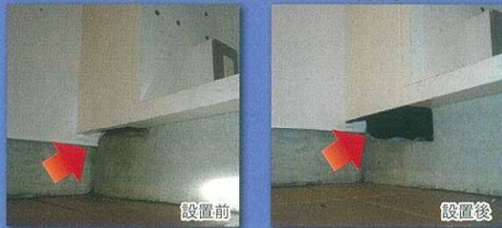
レストラン厨房のカウンター隙間
